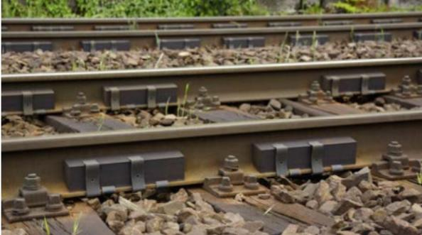
Abbildung 55: Schienenstegdämpfer im Verlauf der Elbtalstrecke.
