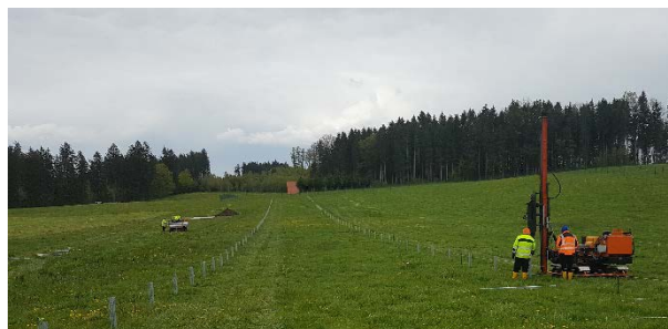
Abbildung 3: Hydraulikramme auf Ketten
