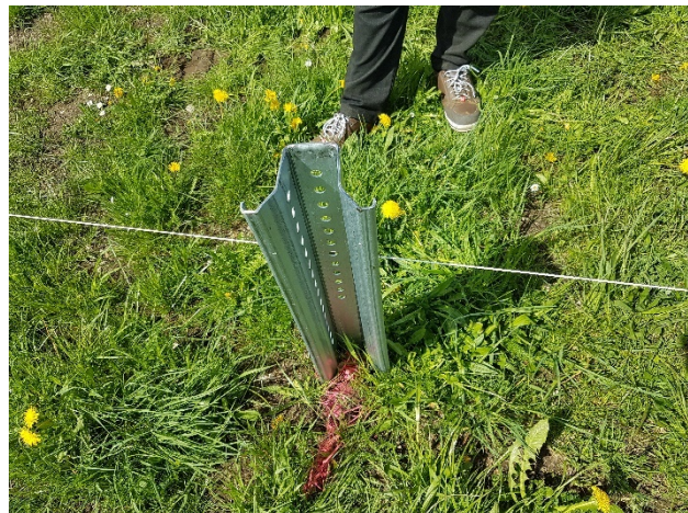
Abbildung 6: Rammfundament
