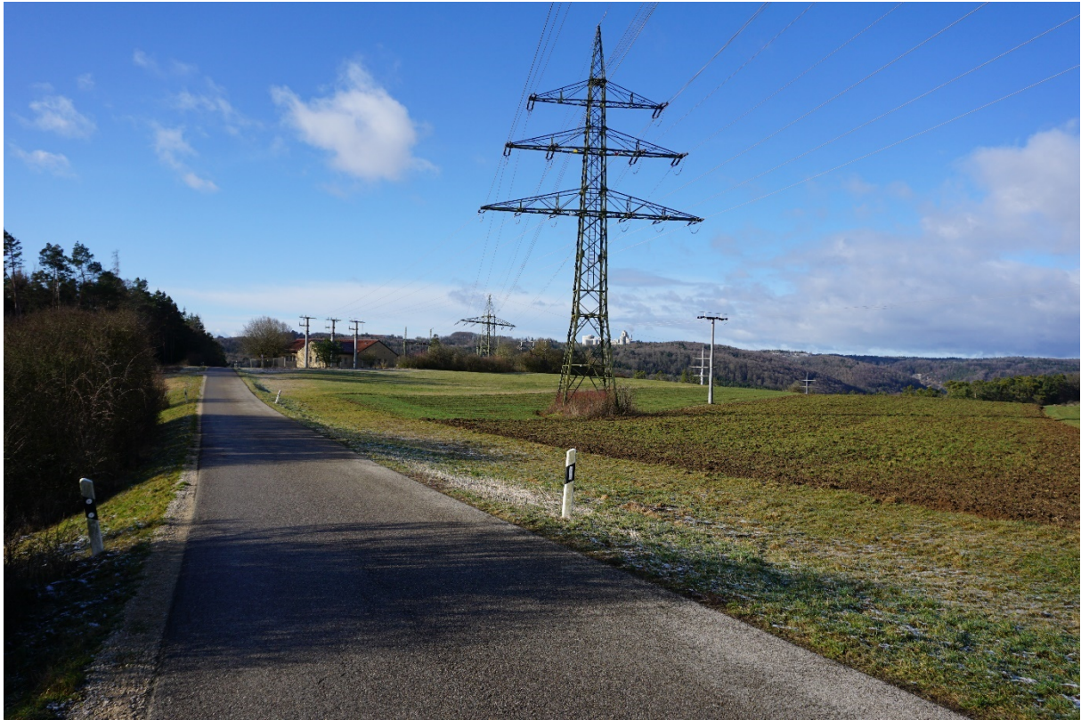
Abbildung 10: Blick von der östlich der Fläche liegenden Ortsverbindungsstraße zwischen Esslingen und Hochholz auf Freileitungen, Umspannwerk
