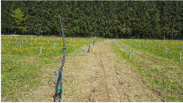
Abbildung 4: Verfüllter Kabelgraben
