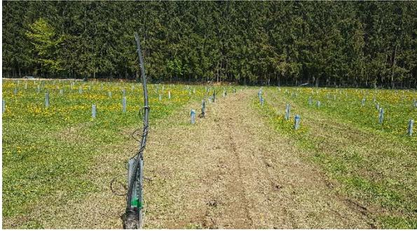
Abbildung 4: Verfüllter Kabelgraben
