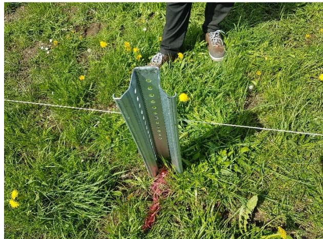
Abbildung 6: Rammfundament
