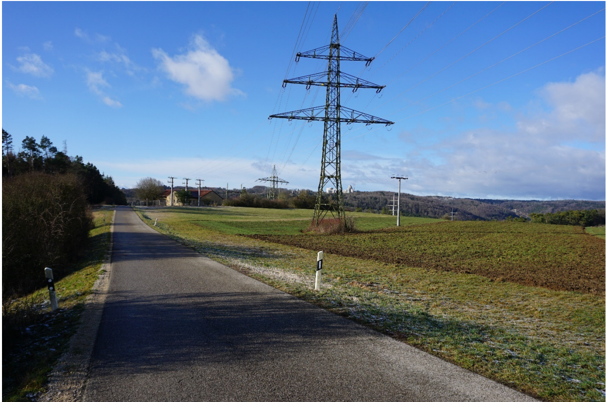
Abbildung 9: Blick von der östlich der Fläche liegenden Ortsverbindungsstraße zwischen Esslingen und Hochholz auf Freileitungen, Umspannwerk
