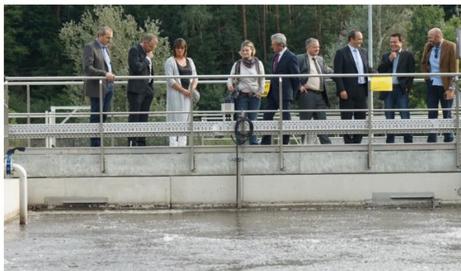
Das Herzstück der neuen Anlage ist das patentierte Biocos-Becken. In bakteriologischen Reinigungsvorgängen wird aus Abwasser von allen Haushalten sowie von zahlreichen Betrieben und Geschäften wieder sauberes Wasser, das ohne Probleme in die nur wenige Meter entfernte Altmühl geleitet werden darf.
